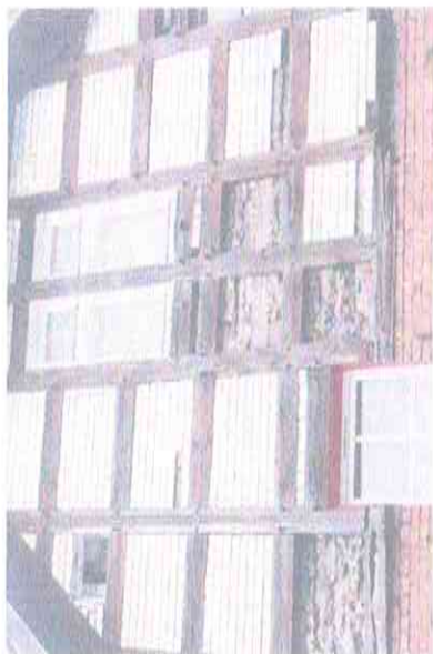
Fot. nr 6. Braki licowych kształtek na znacznych płaszczyznach muru wtórne okno w pasie poddasza.
