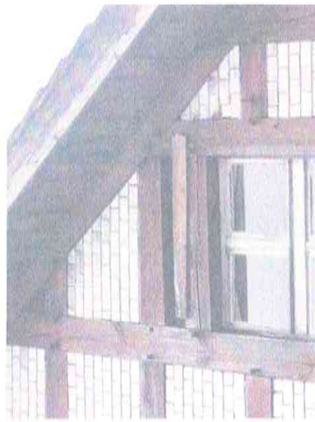
Fot. nr 5 Wtórny obłuzowany element drewniany nad oknem.
