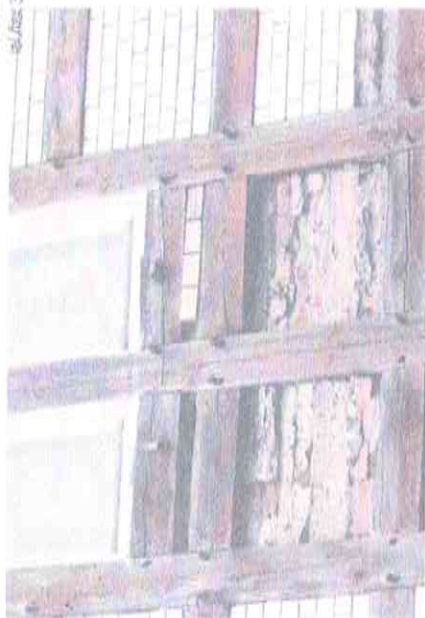
Fot. 8 Brak tynków na ciałych płaszczach muru, przykładowe obliczowanie pojedynczych kształtek pod belką podokienną
