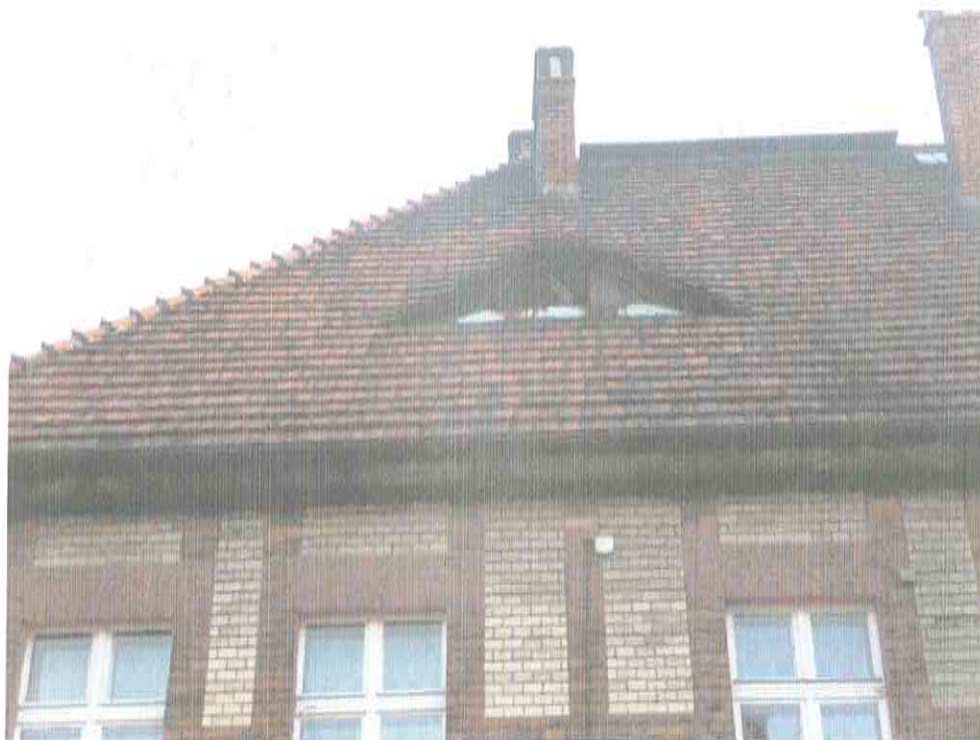
Fot. 12 - "powieka" w dachu budynku przy ul. Wolności 9 - jako wzór do odtworzenia
