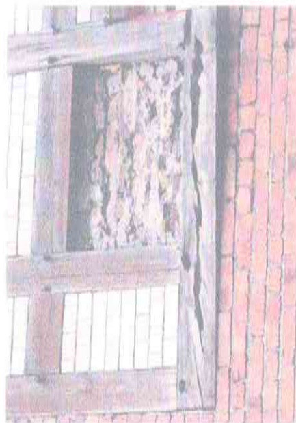
Fot. nr 3. Spękana, wypróchniała podwalina po lewej stronie ryzalitu.
