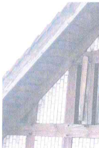
Fot. nr 9. Zniszczone deskowanie okapu dachu.
