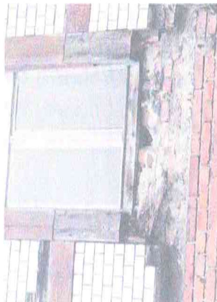
Fot. nr 4 Widoczne ślady po wcześniejszych pracach naprawczych konstrukcji - wymiana zniszczonych fragmentów słupów, pozostałości pod oknem wypróchniałych belek. Brak okiennego parapetu.
