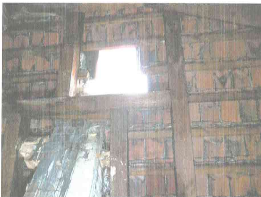
Fot. 8 - więźba dachowa - ubytek poszycia
