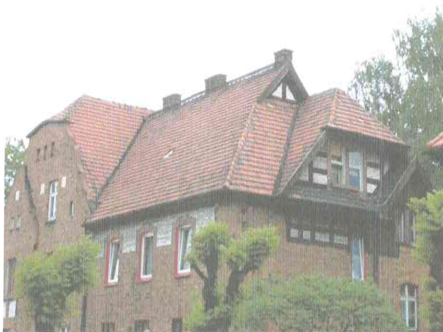
Fot. 4 - elewacja frontowa i boczna południowo-zachodnia z "pólszczytem", brak "powieki" na połaci dachu
