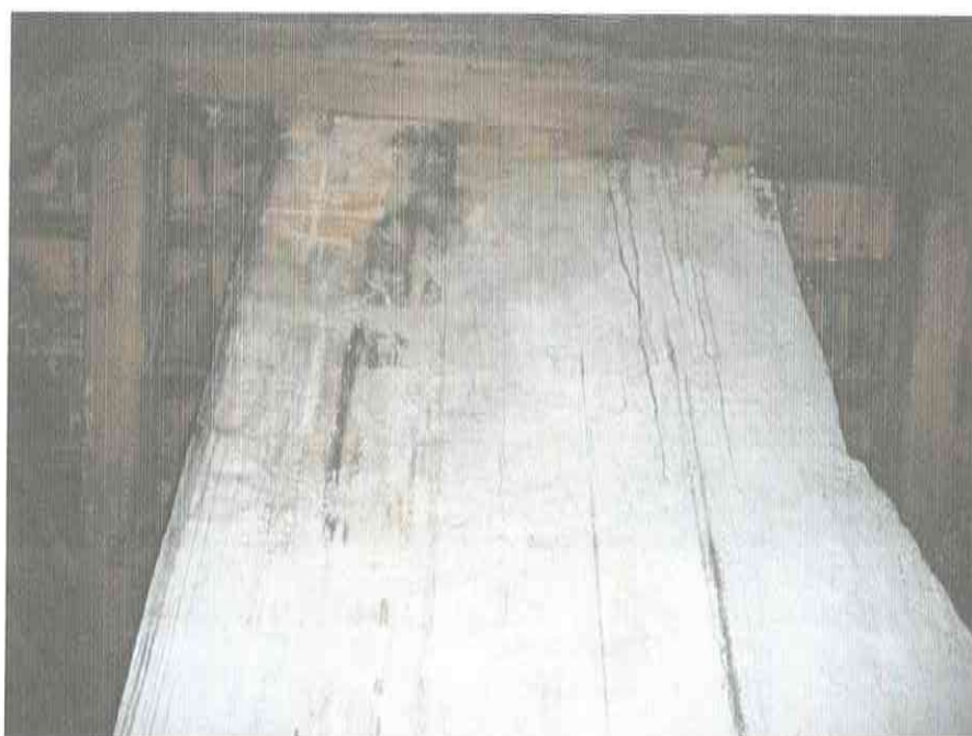
Fot. 10 - komin w przestrzeni poddasza - widoczne ubytki tynku i ślady po zalaniach
