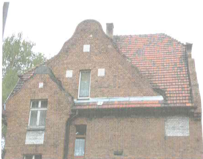
Fot. 5 - elewacja boczna, północno-wschodnia - widoczne szczyty zakończone "rolką"
