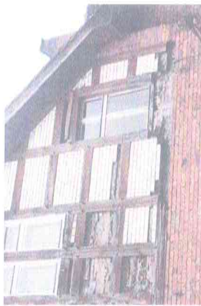
Fot. nr 2 Brak podwaliny prawej stronie ryzalitu.
